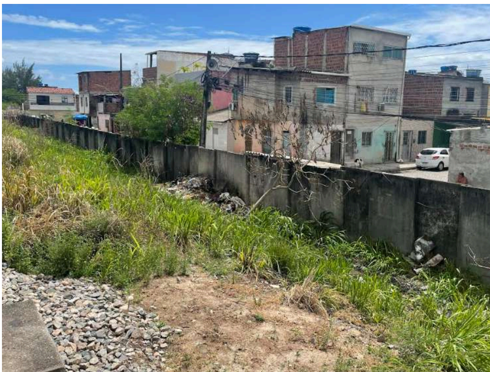
Foto 11: Exemplo de muro de placas pré-moldadas a ser removido para implantação de portão de acesso a área do estaleiro móvel
