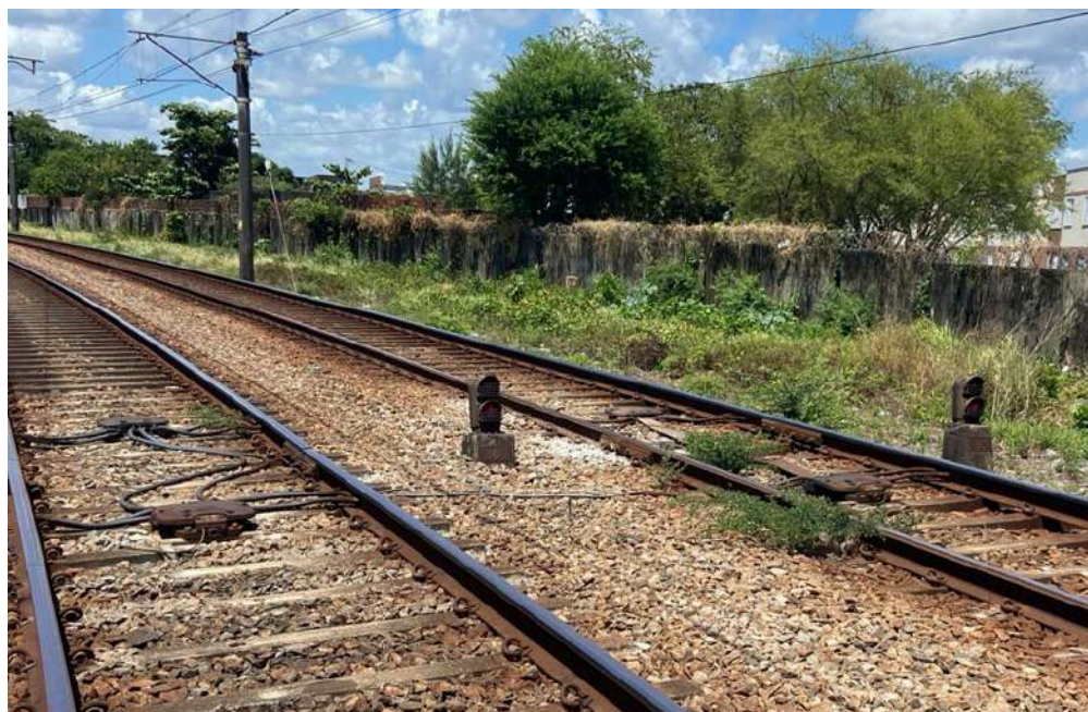
Foto 01: Exemplo de trechos em curva com trilhos a serem substituídos na Linha Centro
