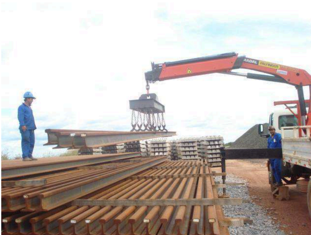
Foto 18: Implemento para manuseio de trilho e forma correta de armazenagem
