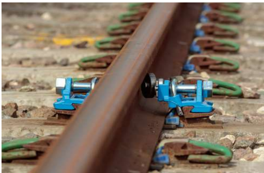
Foto 29: Roletes para alívio de tensões
