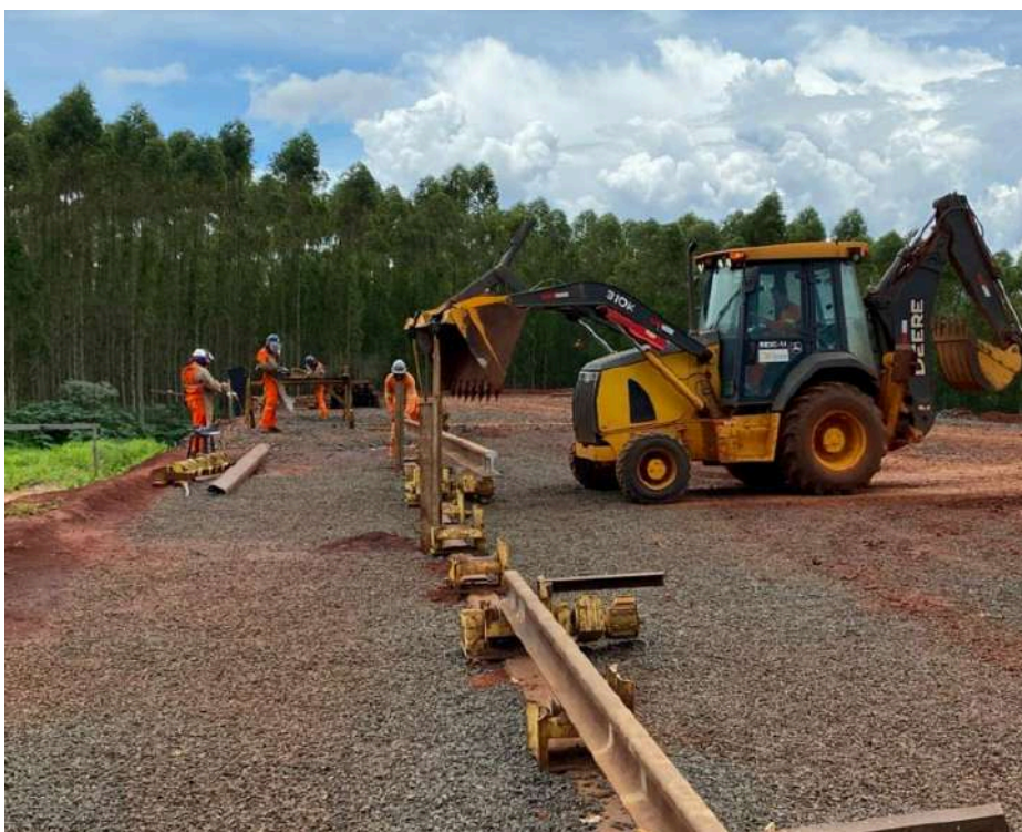
Foto 21: Posicionamento de trilhos sobre roletes com a utilização de equipamento
