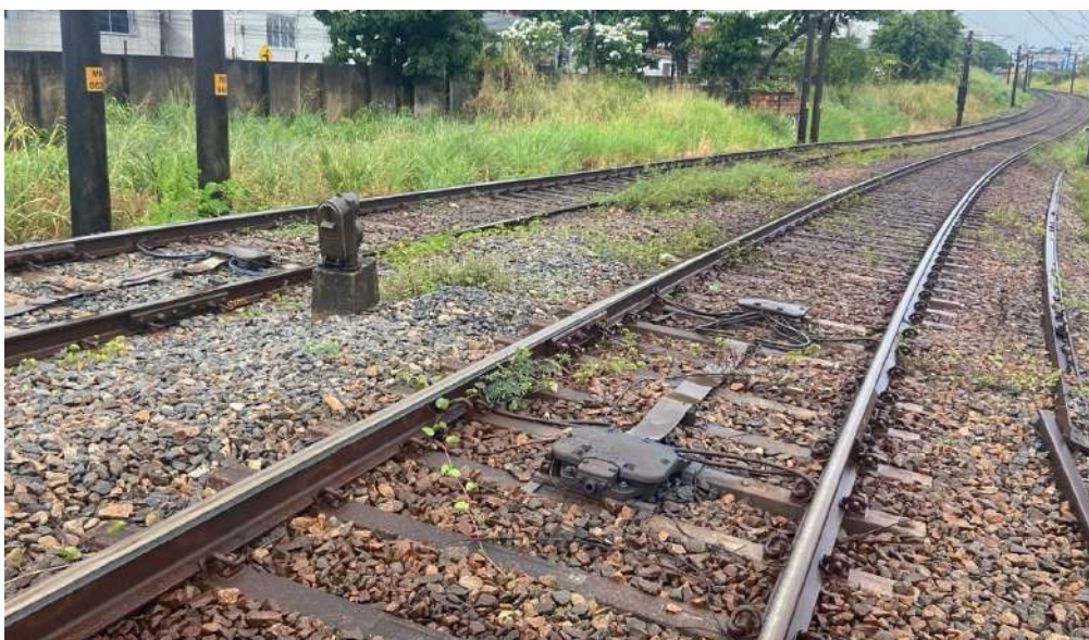
Foto 03: Vista de trecho em curva com trilhos a serem substituídos (Linha Centro)
