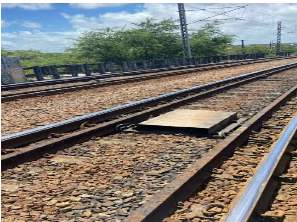
Foto 04: Outra vista de trecho em curva com trilhos a serem substituídos (Linha Centro)
