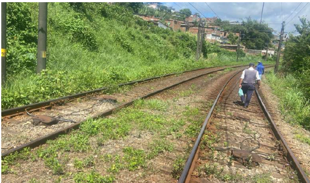
Foto 04: Outra vista de trecho em curva com trilhos a serem substituídos (Linha Centro)
