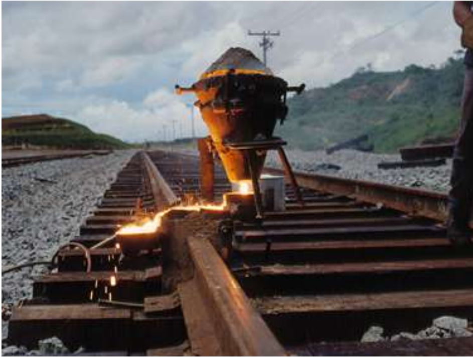
Foto 27: Solda Aluminotérmica
