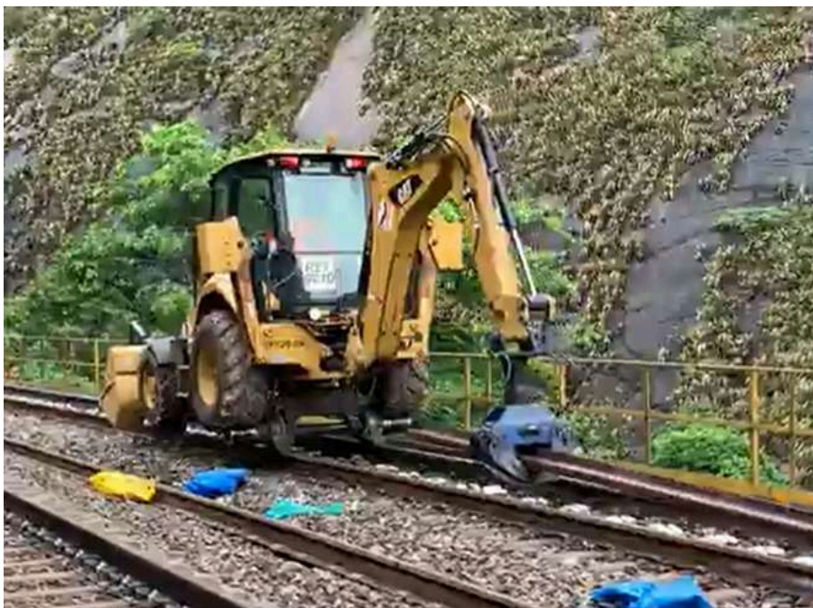
Foto 21: Posicionamento de trilhos sobre roletes com a utilização de equipamento
