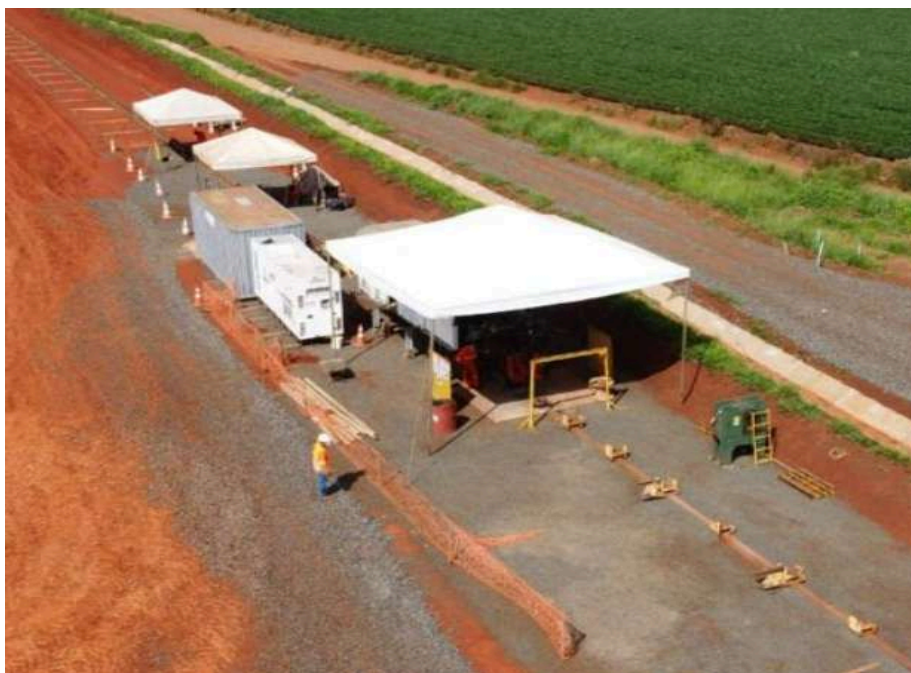
Foto 31: Visão ampliada de um estaleiro de solda móvel (equipamentos abrigados)
